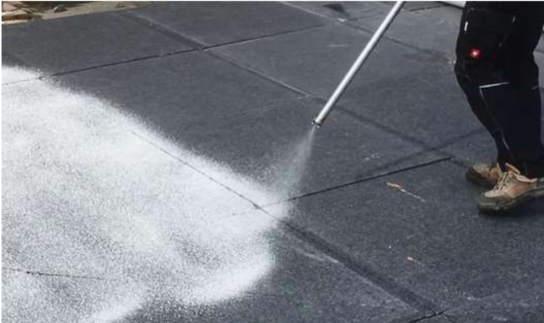
Anwendungsbeispiel: Vollflächiger Klebstoffauftrag eines sprühfähigen PU- Dachbahnenklebers.
